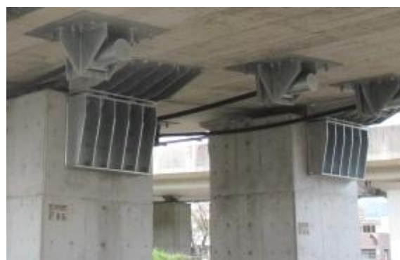
タナカ-AZ の適用製品例（落橋防止ブラケット：左はめっき状況・右は設置状況）
