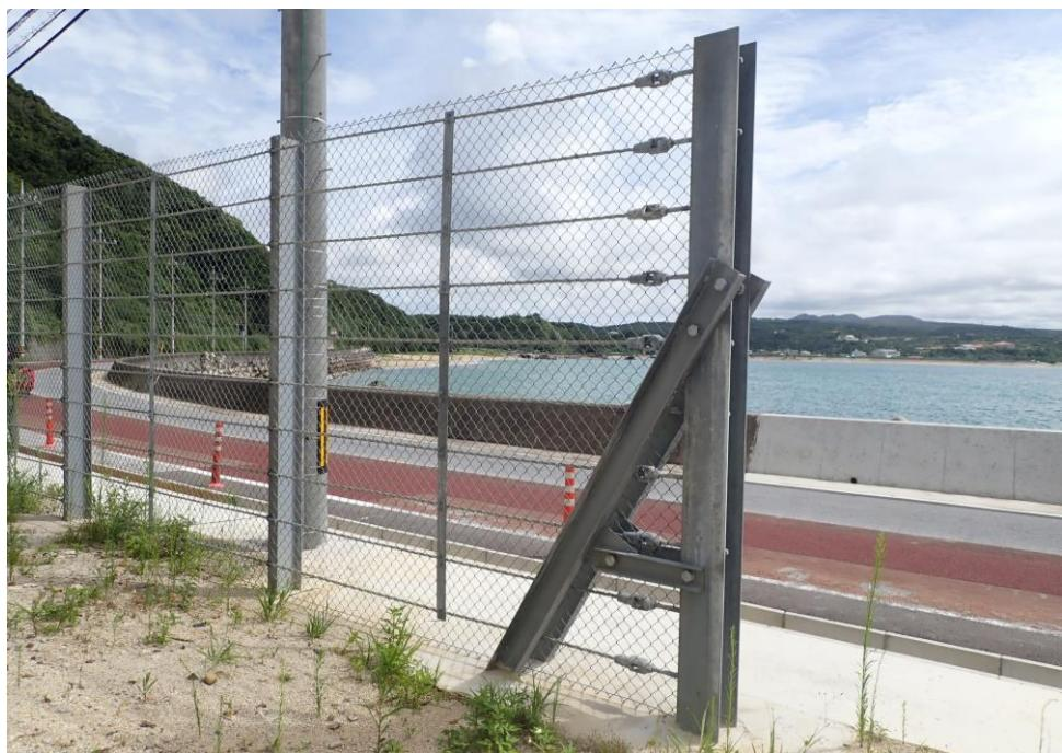
沿岸部の落石防止製品の支柱材に採用されたタナカーアジ
