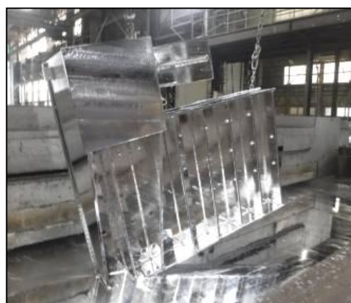
2 トン以上の溶橋防止ブラケットの施工
