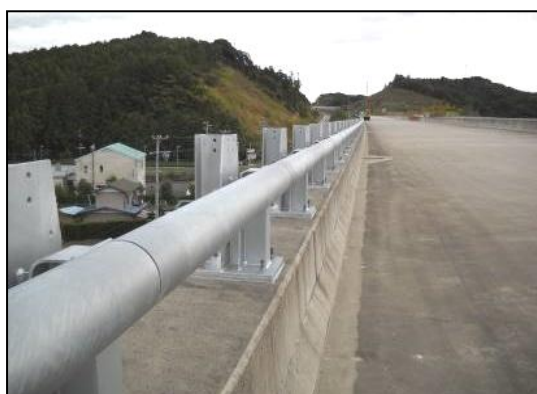
凍結防止剤散布個所の鋼製高欄
