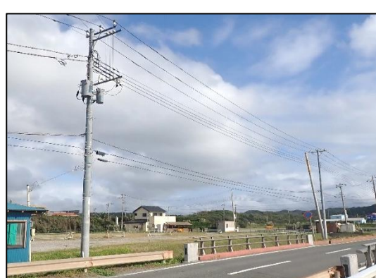
塩害地の配電柱および部材
